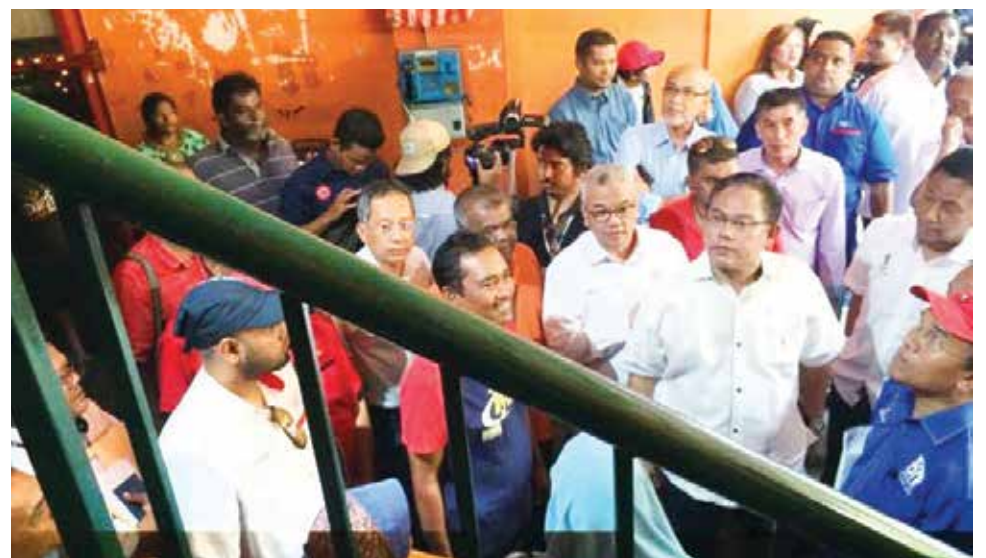
Tan Sri Noh Omar sedang meninjau susur tangga yang rosak di rumah pangsa Desa Mentari serta meluluskan peruntukan RM80,000 bagi membaiki kemudahan tersebut.
