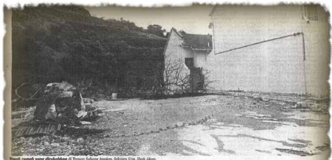
Tampak rumah yang dirobohkan di Taman Subang Impian, Seksyen U10, Shah Alam.
