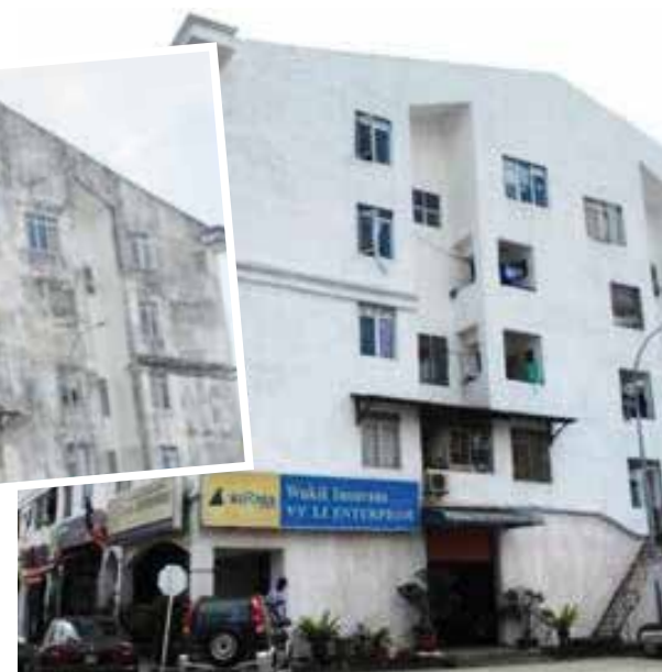
Kerja mengecat Rumah Pangsa Bukit Senjuang, Banda Hilir, Melaka
