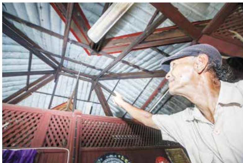
Adam menunjukkan keadaan bumbung yang sudah dibaiki selepas menerima bantuan daripada program baik pulih rumah bandar.
