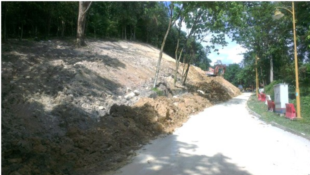
Kerja-kerja pemindahan tanah sedang dilakukan
